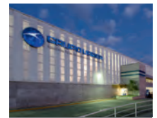
CENTRO DE DISTRIBUCIÓN
