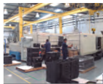
PLANTA DE INYECCIÓN Y EXTRUSIÓN DE PLÁSTICOS
